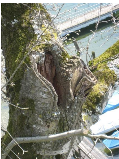
Grössere Faulstelle nach Astung
